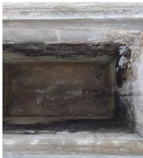
Se realizó limpieza general de toda la red de aguas lluvias y cañerías con que cuenta el conjunto, ya que las cajas de aguas se encontraban llenas de sedimentos sólidos, arena, plásticos y otros objetos, lo cual estaba causando taponamientos y representaba para el conjunto un riesgo de inundación en zona de parqueaderos. Se utilizó sonda eléctrica, así como bomba succionadora para retirar los sedimentos que se encontraban tanto en cajas, como tuberías
