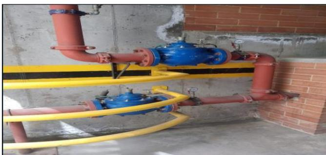
Mensualmente la empresa INGEQUIPOS realiza mantenimiento a las bombas de agua, equipo de Presión, Equipo de RCI, y equipos eyectores. Se cambiaron válvulas flotadoras en los tanques subterráneos, y en tanque aéreo de la torre 9, VAY PASS de bomba de agua sótano, empaques de registros, cambio de regulador para nivel bomba eyectora, cambio de contactor bomba #3, cambio de miple tanque hidroacumulador.
