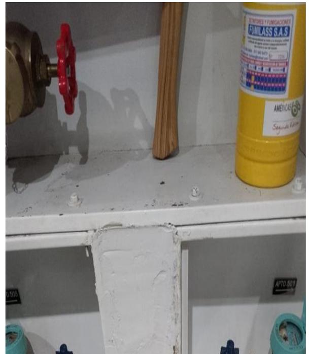
El conjunto cuenta con tubería galvanizada en las instalaciones de la red interna de agua potable que alimentan a cada uno de los apartamentos, con el paso del tiempo esta tubería se deteriora y empieza a presentar filtraciones de agua, para subsanar estos casos se ha reemplazado esta tubería por PVC. A la fecha se han reemplazado un total de 16 flautas por deterioro, de un total de 612.
