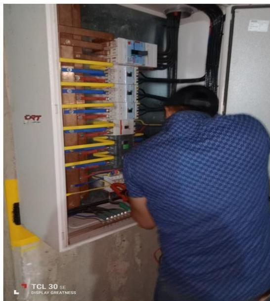
Debido a los continuos picos de energía que se presentan en el sector, los breakers eléctricos se han ido deteriorando, lo que puede causar un riesgo eléctrico, es así que se han venido reemplazando por unos de mayor capacidad y amperaje.
